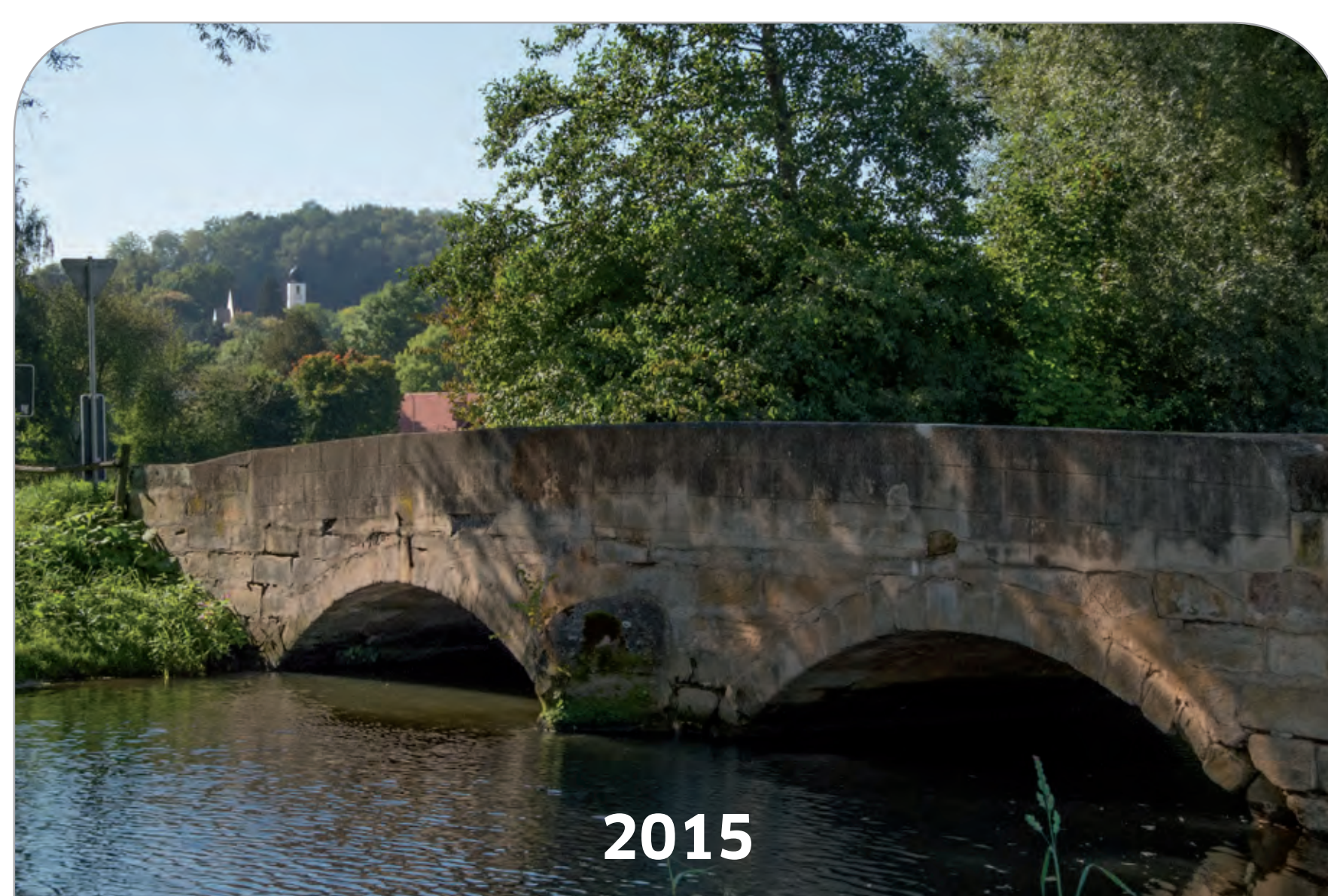
DIE „MAINBRILLE“ Die alte Sandsteinbrücke stammt noch aus der Markgrafenzeit
